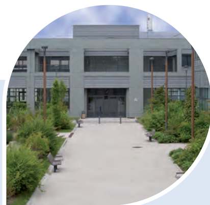
Green Square à Bagneux Exemple d'investissement déjà réalisé. Ne constitue pas un engagement quant aux futures acquisitions.
